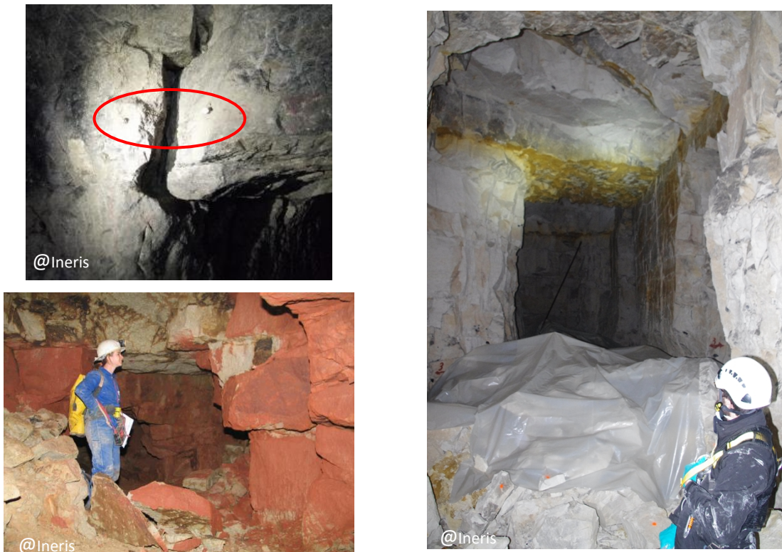
Figures 13 : Exemples d'indicateurs de suivi (témoins, bâche, peinture) dans des carrières de Wallonie et des Hauts-de-France
