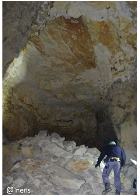
Figure 7 : Remontée de voûte observée en souterrain dans la carrière de la Malogne (Mons, Belgique)
