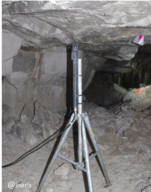
Figure 18 : Dispositif de mesure acoustique dans la carrière souterraine d'Hellemmes (France) – mise en place dans le cadre du projet RISSC
