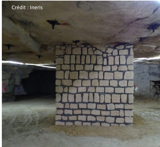
Figures 10 : Exemples de travaux de mise en sécurité (boulons, pilier maçonné...) dans le cadre d'une valorisation de cavité
