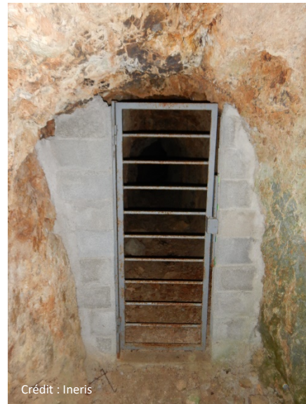
Figures 8 : Exemples de fermeture d'entrée de cavité avec accès spécifique pour chiroptères
