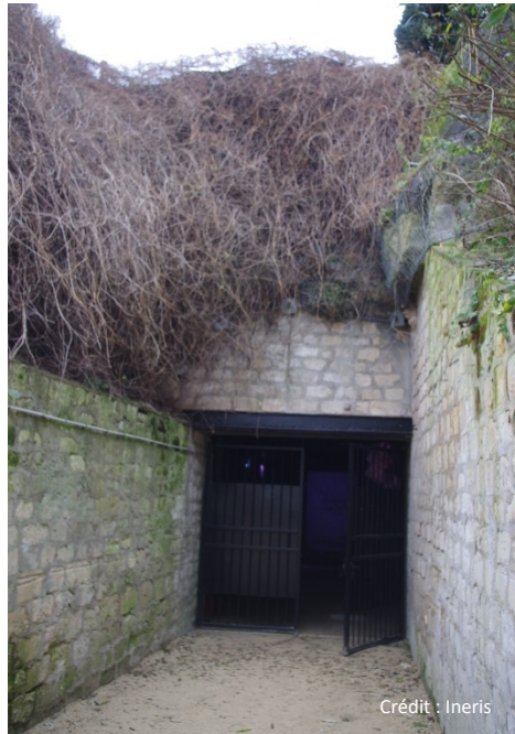
Figure 9 : Entrée principale en flanc de falaise d'une cavité ouverte au public
