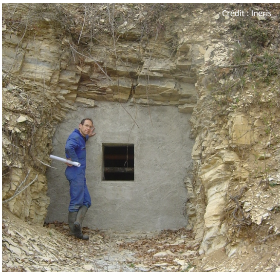
Figures 8 : Exemples de fermeture d'entrée de cavité avec accès spécifique pour chiroptères
