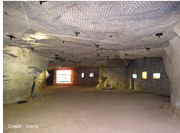
Figure 7 : Plateforme expérimentale et pédagogique de l'Ineris pour l'étude des risques du sous-sol (Oise)
