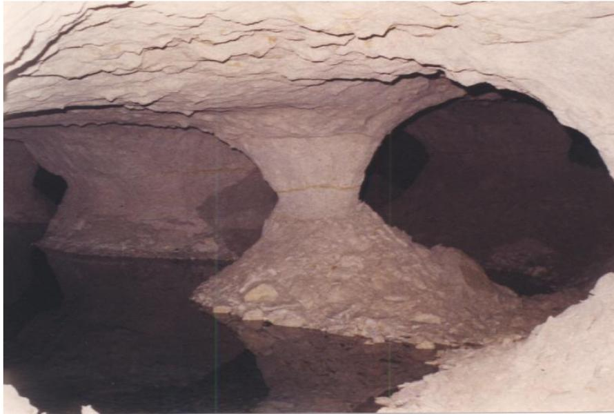
Figure 26 : Exemple de pilier écaillé dans les carrières souterraines de la Malogne (Mons, Belgique).
