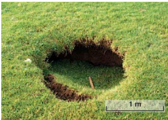
*Figure 9 : photographie d'une rupture de bouchon de puits (source : LCPC)*
