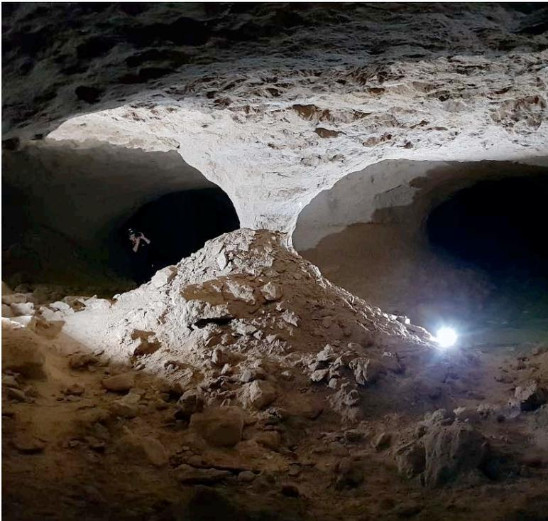
*Figure 10 : photographie d'un pilier en diabolos, carrière de la Malogne*
