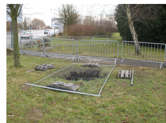
Ouverture d'un puits par chute d'un bouchon (carrière à Hellemmes-Lille)
