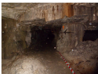
Mode d'exploitation en chambres et piliers (carrières de Lezennes)
