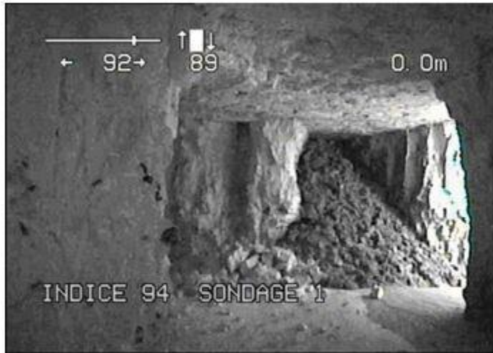
Visualisation d'une galerie de carrière par caméra vidéo (Photographie Introvision - Île de France)
