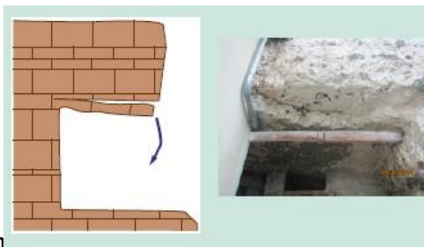
Décollement de la dalle de toit
