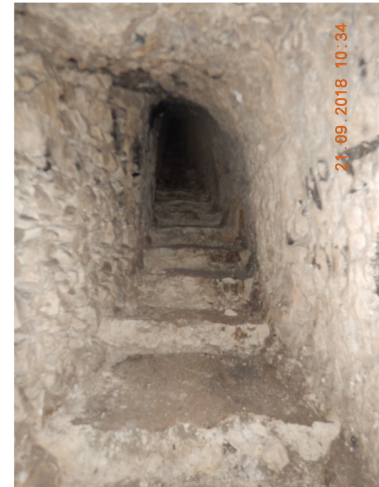
Descenderie carrières Wellington ARRAS photo DDTM 62
