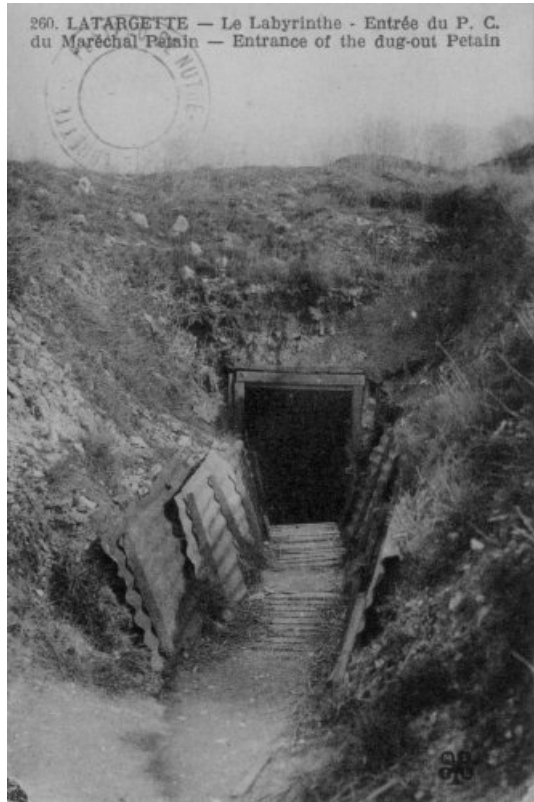
Entrée de tranchée souterraine LA TARGETTE
