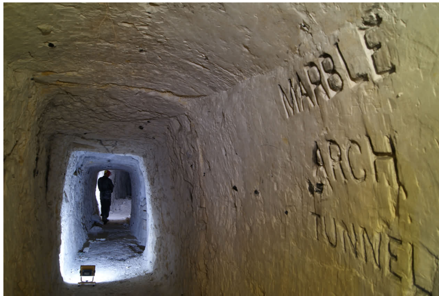
Tunnel ÉTAPLES-SUR-MER – photo association ARRRAS
