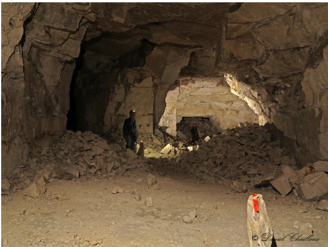
Carrière souterraine ARRAS photos BE Semofi
